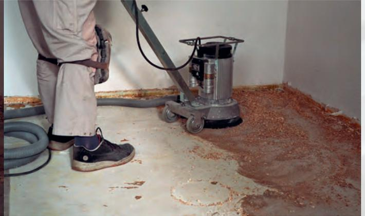
PKD-Frässcheibe 250 NT mit Stützsegmenten: Entfernen eines CV-Restbelages inkl. Kleber
